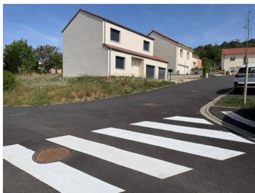
Passage piéton et enrobé neuf
