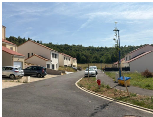
Voirie définitive rue de la Mine
